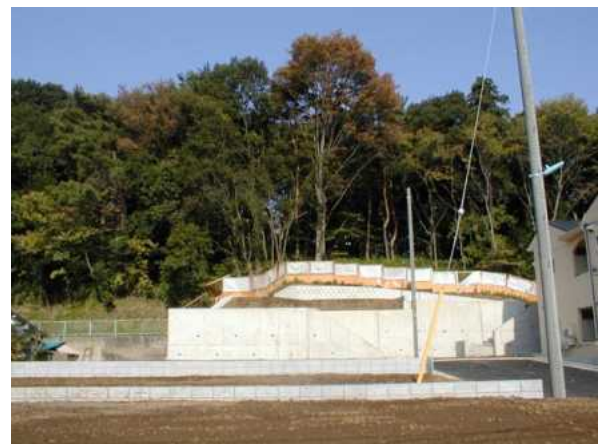
国分寺崖線の際で進む宅地造成（東元町3丁目）
