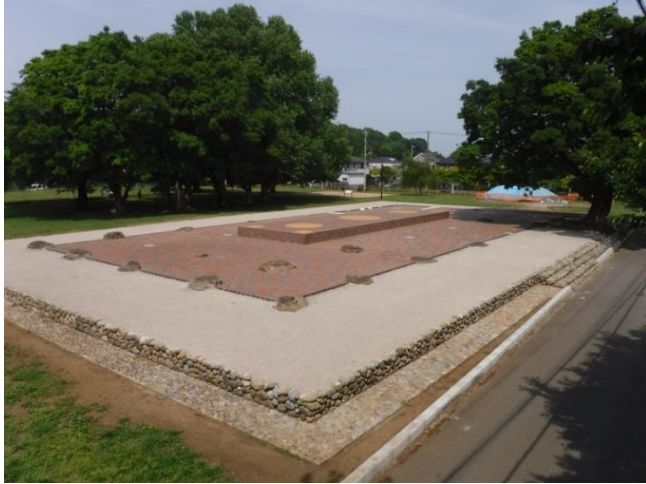
〈平成29年度金堂基壇復元工事状況〉
