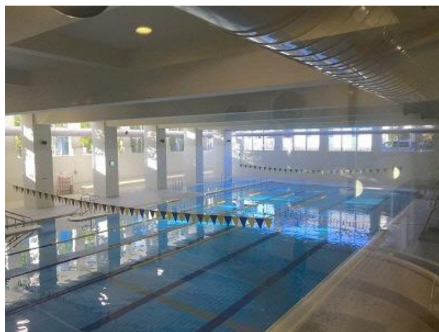
学校プールの例（調布市立調和小学校）
