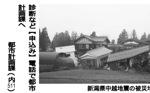
新潟県中越地震の被災地
