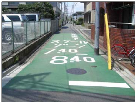
■カラー舗装による注意喚起例
