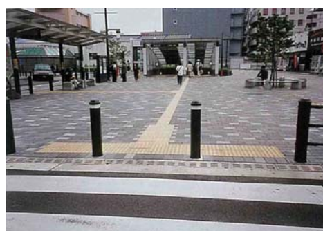
■ 車道と歩道の段差のない歩行空間の整備例
