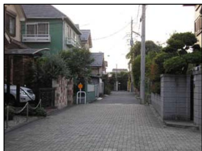
■狭隘道路が拡幅された事例
