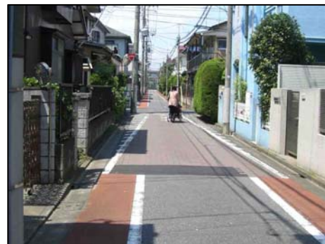
■カラー舗装による速度軽減対策例
