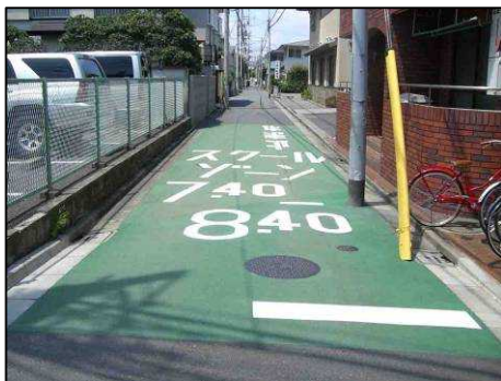
カラー舗装による注意喚起例
