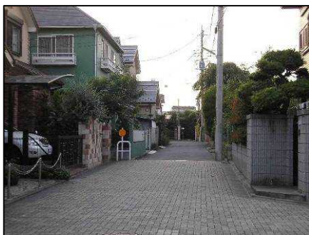
狭隘道路が拡幅された事例
