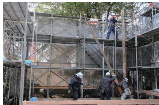
長屋門保存修理工事風景
