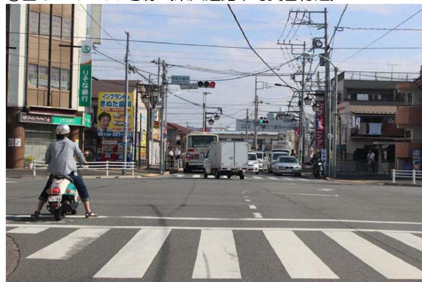
④国3・4・11号線（東八道路栄町交番付近）
