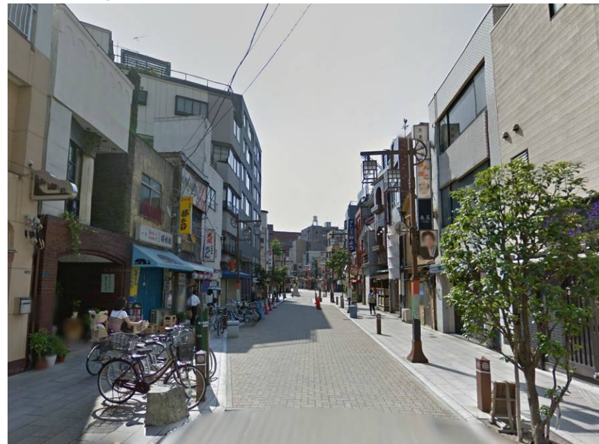
○歩行者と車道を分離しつつ、コミュニティ道路として整備。沿道は主に商業施設や事務所ビルが立地（撮影場所；東京都墨田区浅草）
