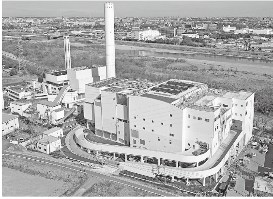
新可燃ごみ処理施設全景 新施設上空より撮影 (令和2年2月 浅川清流環境組合提供)
