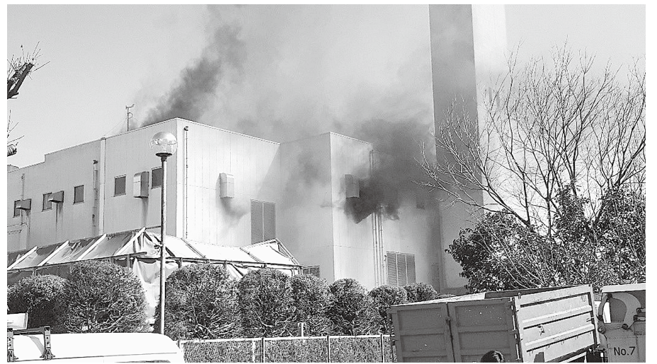
火災が発生した清掃センター3階部分
