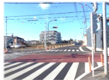
西町三丁目交差点(工事中)
