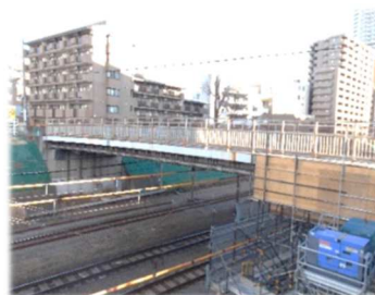
花沢橋(工事中)
