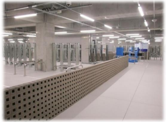
国分寺駅北口地下自転車駐車場
