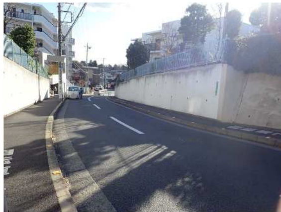
図 3-6 起伏の激しい箇所
