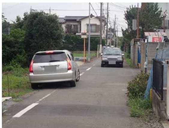
図3-4 車両のすれ違い困難区間
