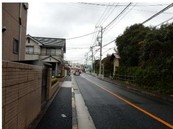
図3-3 内藤橋街道の狭幅員箇所
