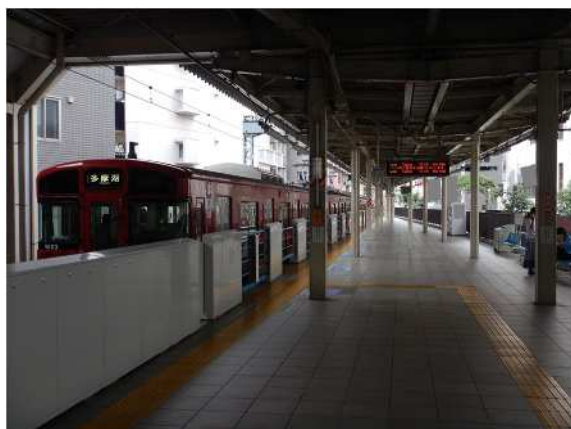
図 5-4 西武多摩湖線国分寺駅ホームドア
