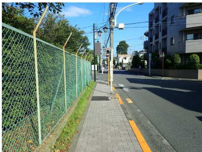
図 5-13 光町通り（電柱が残っている区間）
