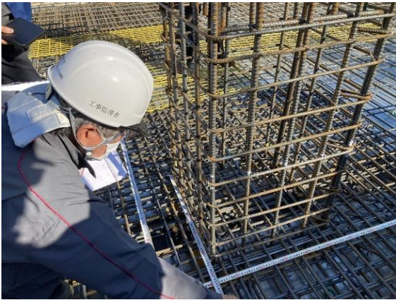
5階設備機器置場のコンクリート打設前の配筋検査の状況です。配筋種別やピッチ、かぶり厚さ、設置状況について確認しています。(10/20)
