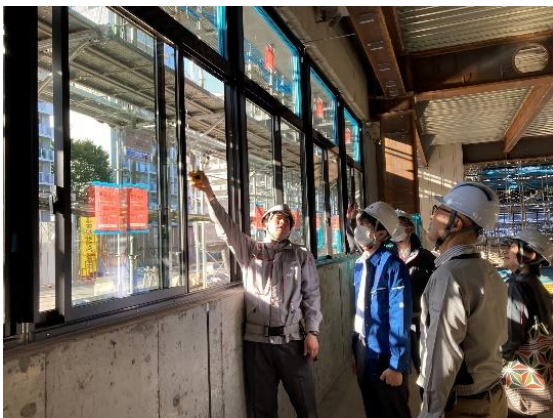
1階西側では、アルミサッシ及びガラス窓が順次取り付けられています。(10/20)
