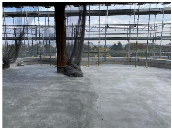
サイトPCヤードで製作されていたテラスが5階に設置されていました。(10/31)
