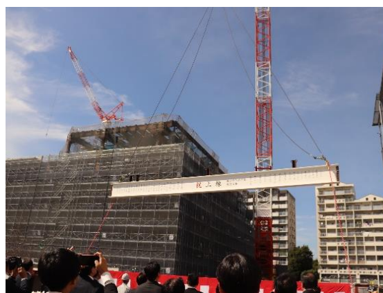
3節の鉄骨も組み上がり、上棟式を執り行いました。(10/3)
