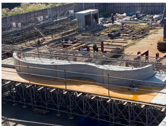
サイトPCヤードでは、5階フロアのテラスが製作されています。(10/13)
