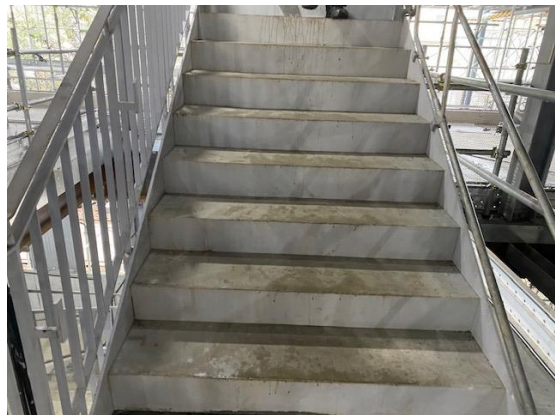
鉄骨階段の踏面部分のモルタル打設後の状況です。(10/4)
