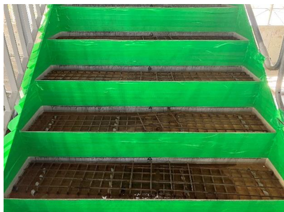
鉄骨階段の踏面部分のモルタル打設前の状況です。モルタル打設部分以外はしっかりと養生されていることを確認しました。(9/12)
