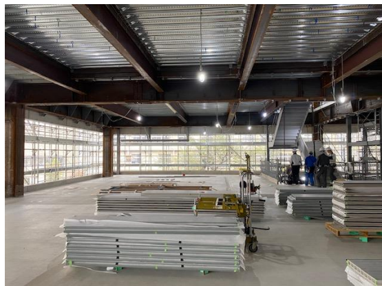
2階床スラブのコンクリート打設後の状況です。外壁などの資材が整理して置かれています。(10/4)
