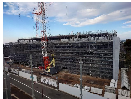
いずみプラザ屋上から現在の全景(10/20)
