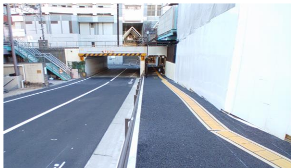
市道南290号線(工事中)
