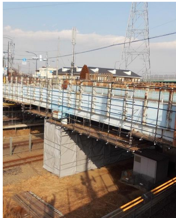
内藤橋(工事中)
