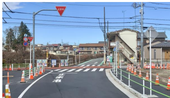
西恋ヶ窪四丁目交差点(工事中)
