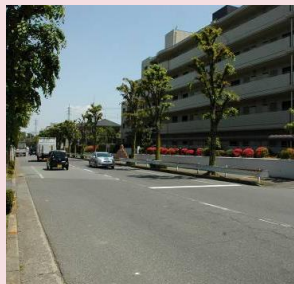
国3・4・6号線 （一部区間／日吉町四丁目付近）
