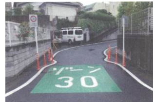
進入抑制対策の例(船橋市)
