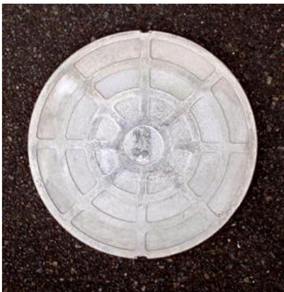
雨水は内部の穴などから地下に浸透していきます。
