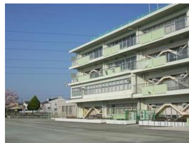
■地区防災センター（第十小学校）
