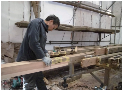
柱（スギ）の継手調整
