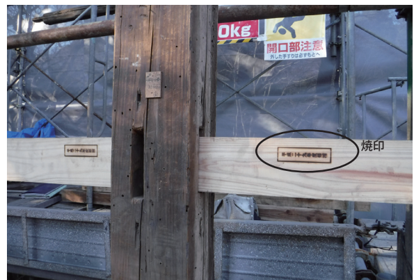
貫（スギ） ※新規材料への焼印
