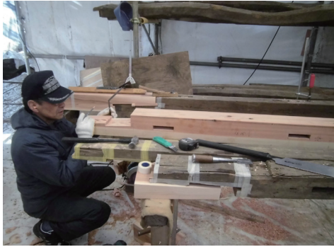
柱（スギ）の継手（金輪継ぎ）加工
