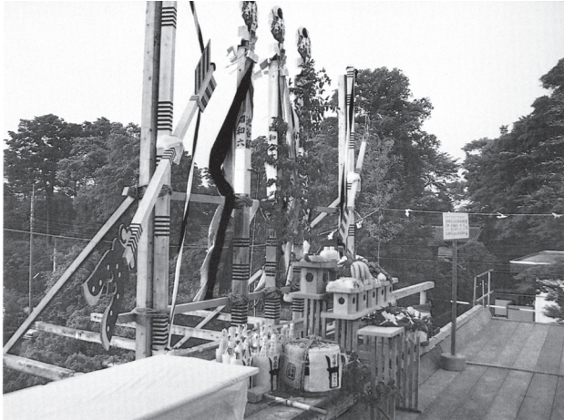
上棟式の飾り 中藤新田（国分寺市西町）池谷一家 昭和 61（1986）年
