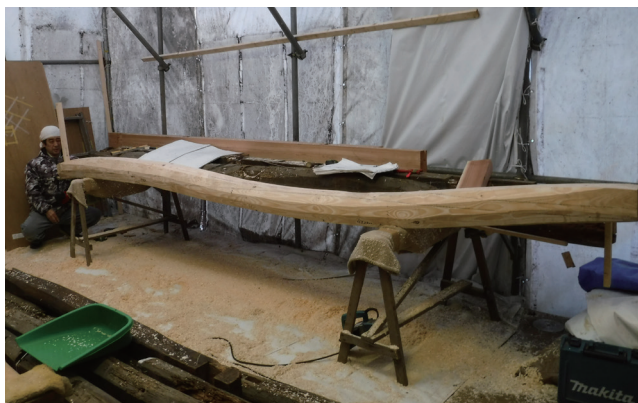
小屋梁（マツ）新規材料の加工 ※既存材と同じ屈曲を復原
