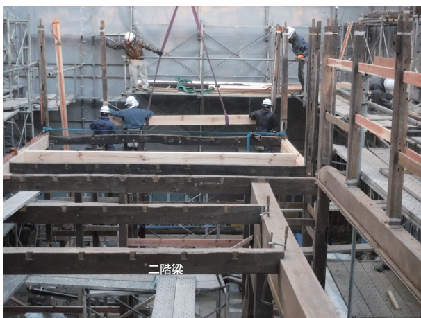
2 階梁の設置（平成 29 年 1 月 13 日）西から
