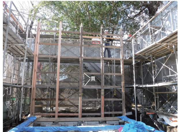
柱に貫を通して固定（平成 29 年 1 月 10 日）東から
