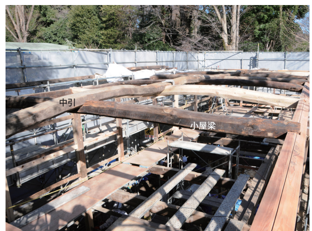
小屋梁・中引がかかりました（平成 29 年 1 月 16 日）南西から
