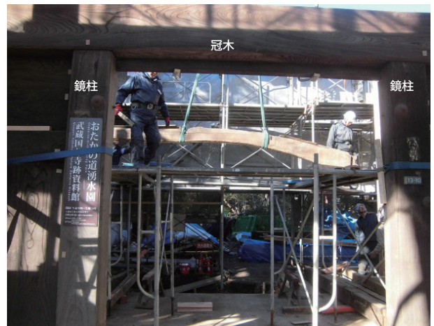
通路部分の組立（平成 29 年 1 月 12 日）南から
