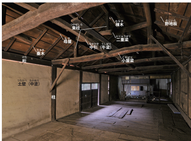
解体前の小屋組 西から撮影
