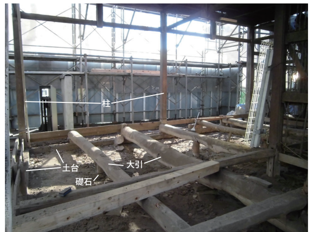
根太撤去後の六畳 北西から撮影
