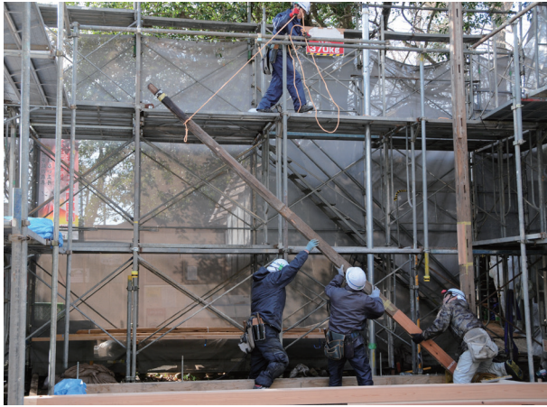
柱を建て始めました（平成 29 年 1 月 9 日）東から
