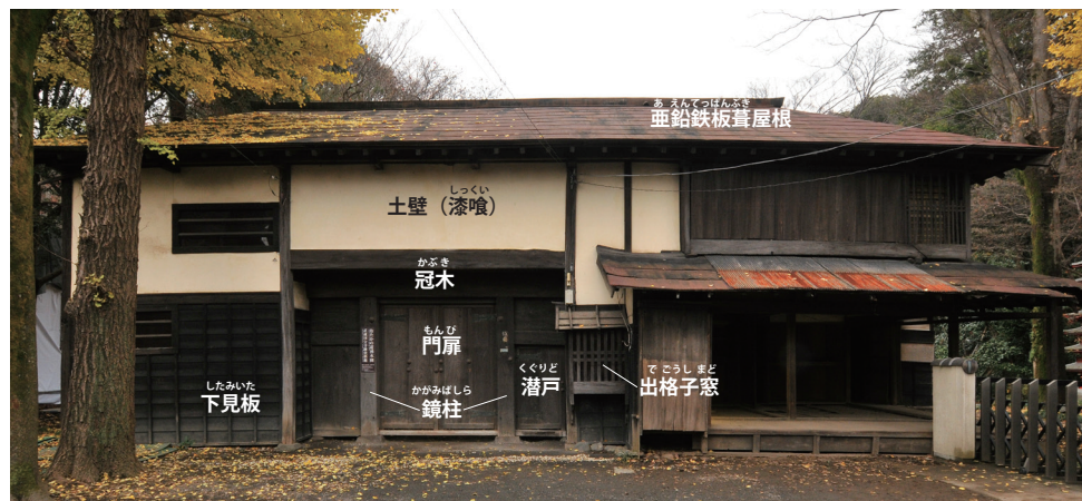
解体前の長屋門 平成 28（2016）年 12 月 15 日 南から撮影
