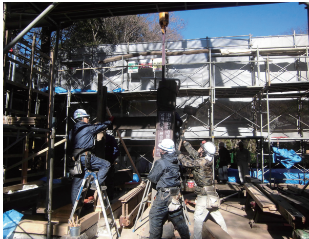
鏡柱の設置（平成 29 年 1 月 12 日）南から
