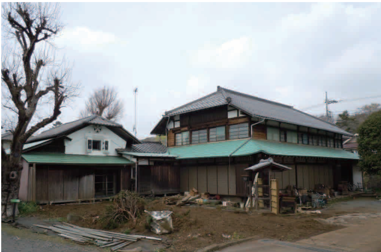
主屋・内蔵解体前の現況(南東から)
