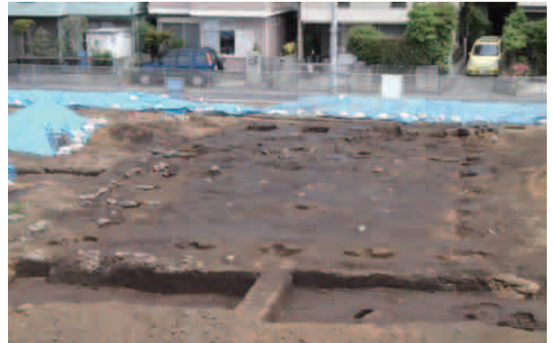
写真① 主屋解体後の基礎状況(南東から)
