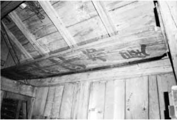
土蔵2階南東看板転用棚（北西から） 表『御休所 やなぎ屋』、裏『待合 御休所 柳屋』
