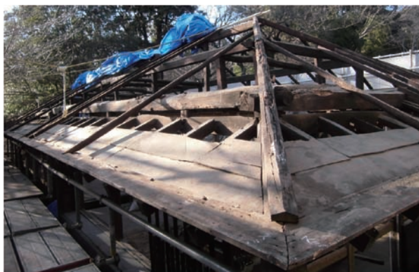
屋根解体状況（南東から）平成28年1月22日
