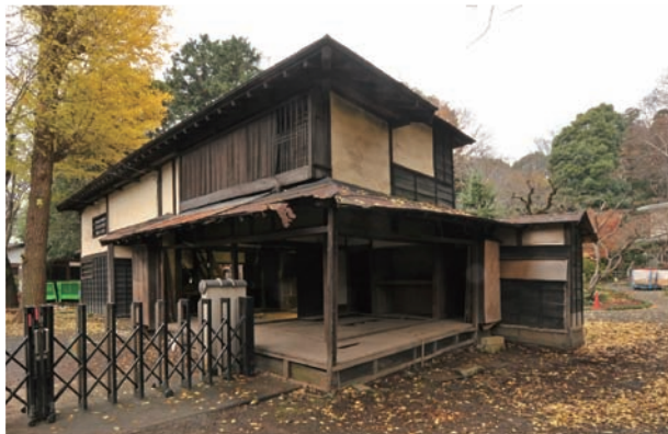
解体前の長屋門（南東から）平成27年12月15日
