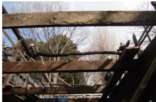
小屋梁解体状況（西から）平成28年2月12日
