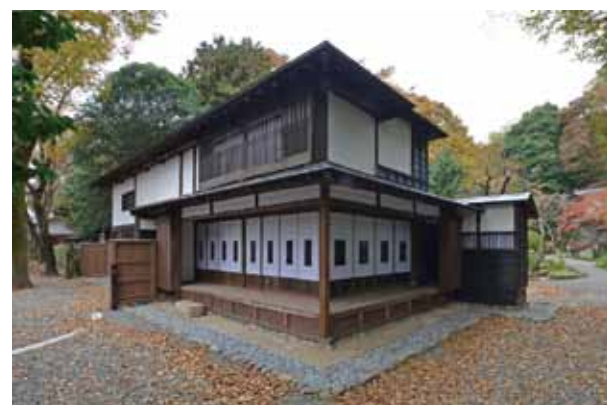
長屋門全景（南東より）
