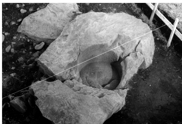
塔心礎 七重塔の中心柱を受ける礎石です。大きさ2.16×1.36mの巨石で、中央に直径73cm、深さ45cmの穴が開いています。
