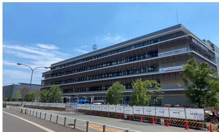
令和7年から供用開始する新庁舎
