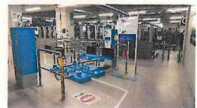
駐車場エントランス付近
