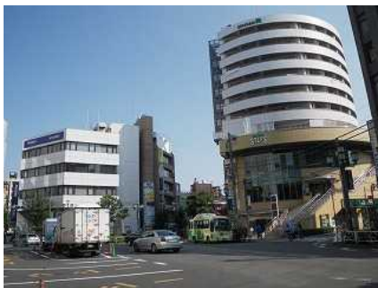
③国分寺駅周辺の住商複合施設 (南町3丁目) 駅周辺には住商複合施設が存在し、活気やにぎわいを印象付ける景観を形成しています。
