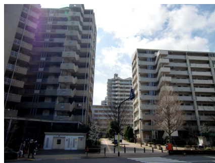
⑥西国分寺駅周辺の中高層住宅集積地(泉町2丁目) 駅周辺には生活利便施設とともに、大規模 な居住施設が建ち並んでいます。
