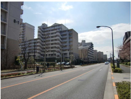
⑦西国分寺駅周辺(泉町2丁目) 電線の地中化や、街路樹の植栽、整ったま ちなみなど、すっきりした印象を与える景観 が形成されています。
