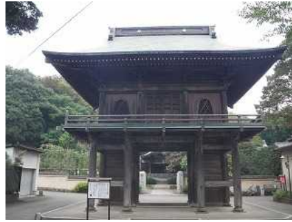
②国分寺楼門 (西元町1丁目) 市指定重宝となっている国分寺の変遷を知る上で重要な建物です。
