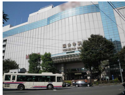
②国分寺駅の複合商業施設 (南町3丁目) 駅舎と一体となって、市の顔としての印象を与えています。
