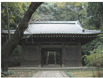
④国分寺仁王門 (西元町1丁目) 仁王門の先には薬師堂があり、周囲の緑と一体となって歴史的な景観を形成しています。
