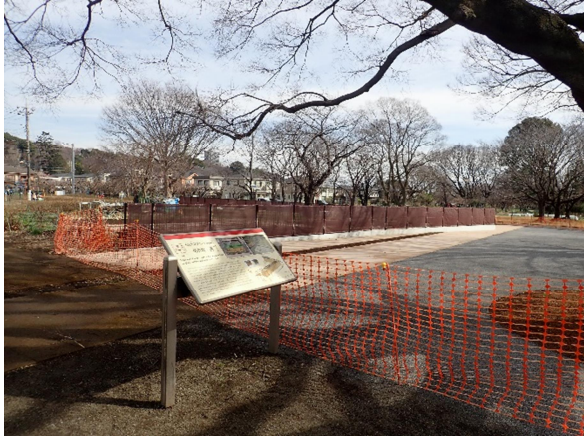
中枢部区画施設平面表示（西から）奥が R7 施工
