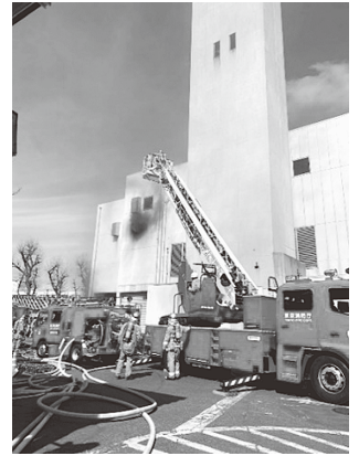
火災消防隊による消火の様子 (令和2年2月19日)
