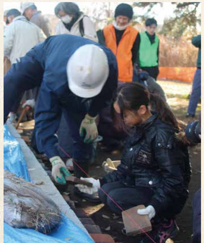
手作り瓦を基壇に埋め込む作業の様子
