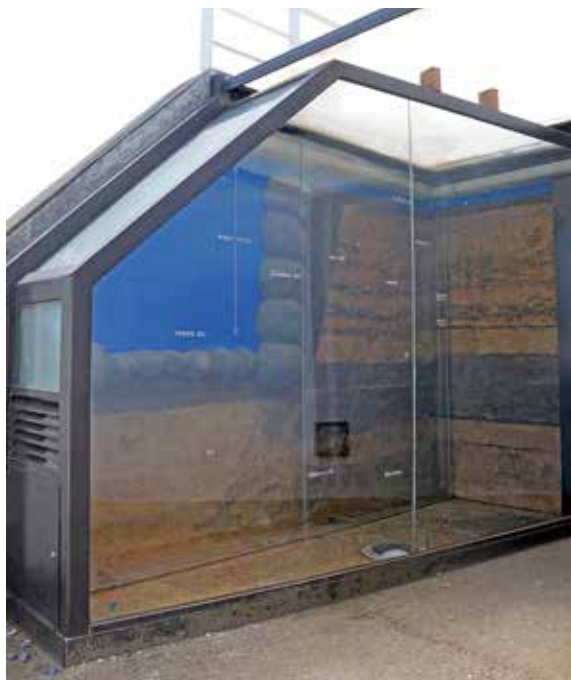
金堂基壇版築観察施設(北西から)
