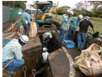
工事立会状況
