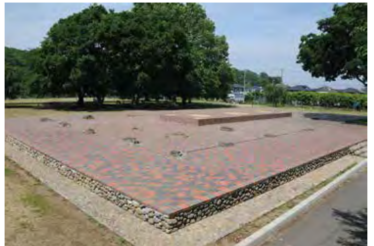
金堂基壇整備後の全景(南西から)
