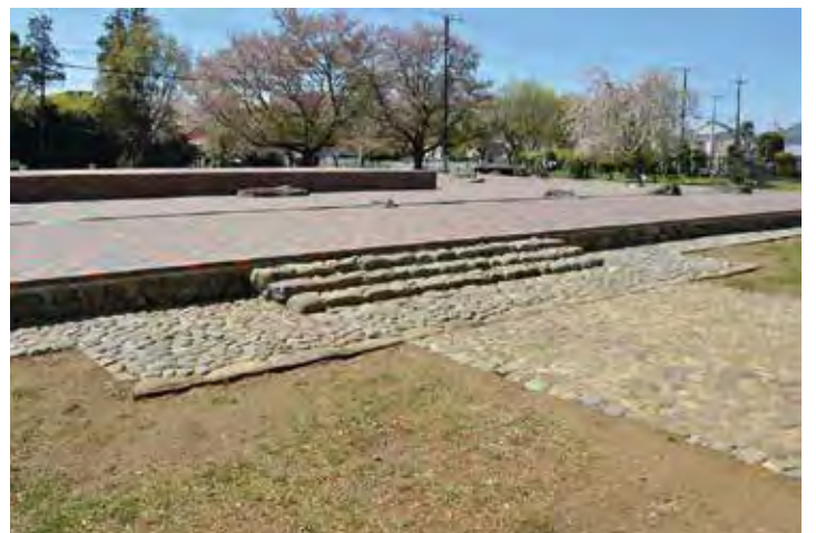
北面階段・雨落石敷の整備状況(北東から)
