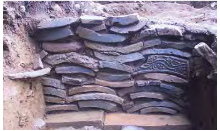
発掘調査で検出された再建時の瓦積基壇外装(北面中央付近/左ページ▼②印)
