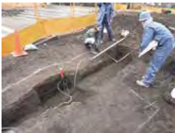
工事立会状況(白線部分が粘土検出範囲)
