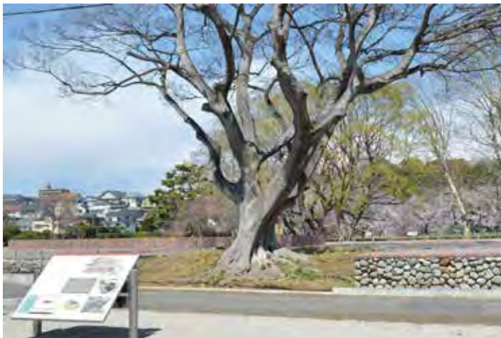
金堂基壇整備後の全景(南東から)
