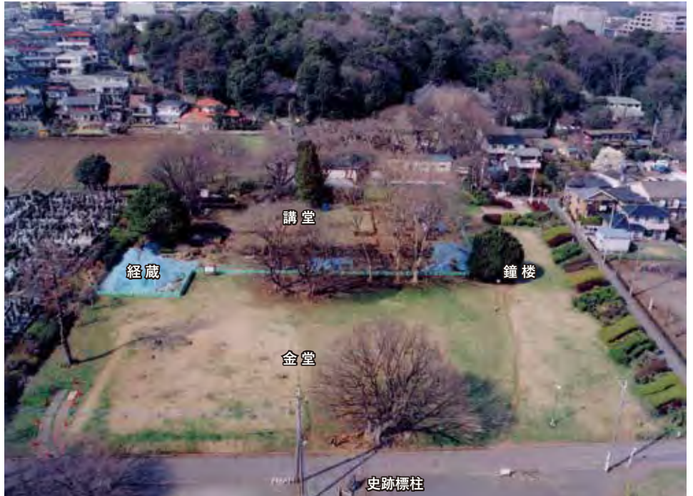
整備前の中核地域(南から/平成21年度) ※講堂発掘調査中
