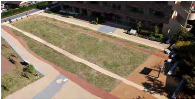
東山道武蔵路(西元町地区)整備状況(南西から)
