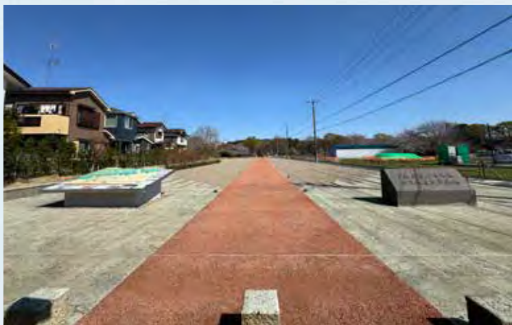
南エントランス広場と参道(南から)
