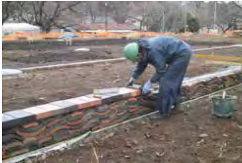
瓦積基壇復元整備工事の様子(平成25年度施工)
