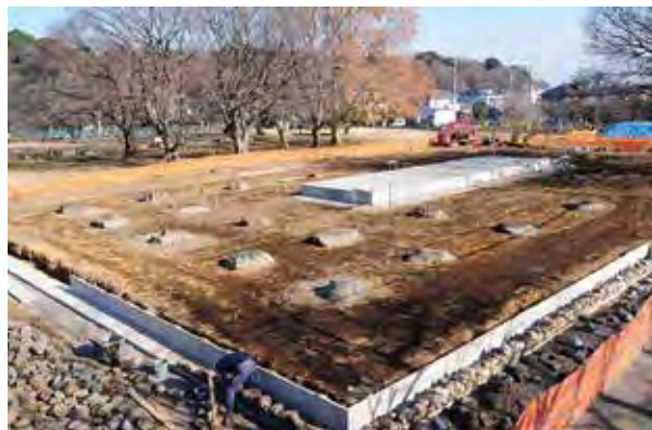
整備工事の様子(南西から/平成29年12月撮影)
