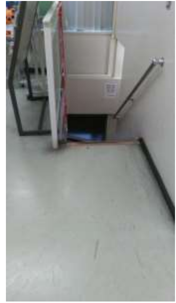
⑤階段上端部への点状ブロックの設置
