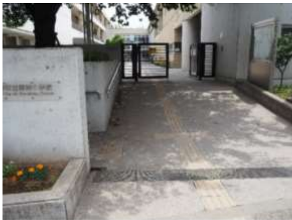
道路から主要な出入口までの経路の段差解消済み
