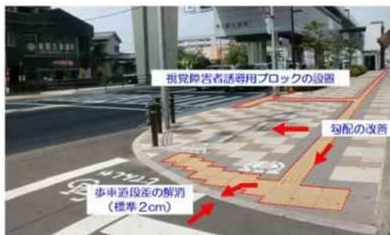
図 8-18 バリアフリー化整備事例
