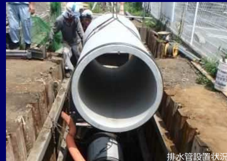
排水管設置状況
