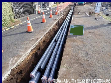
電線共同溝(管路部)設置状況
