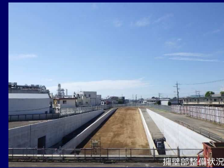
擁壁部整備状況
