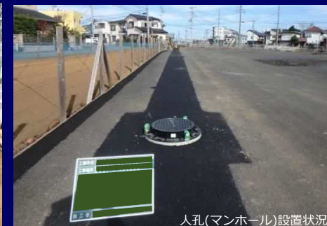
人孔(マンホール)設置状況
