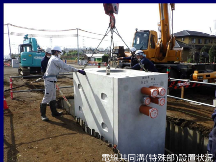
電線共同溝(特殊部)設置状況
