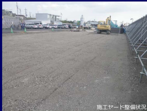
施工ヤード整備状況
