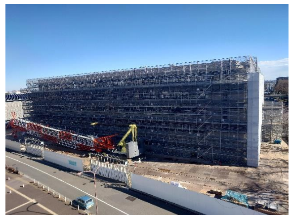
いずみプラザ屋上から現在の全景(1/4)
