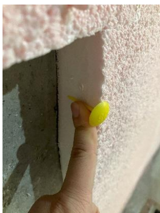
外壁内側には断熱材が吹き付けられています。写真のピンを用いて、適切な厚みが確保されていることを確認しました。(11/24)
