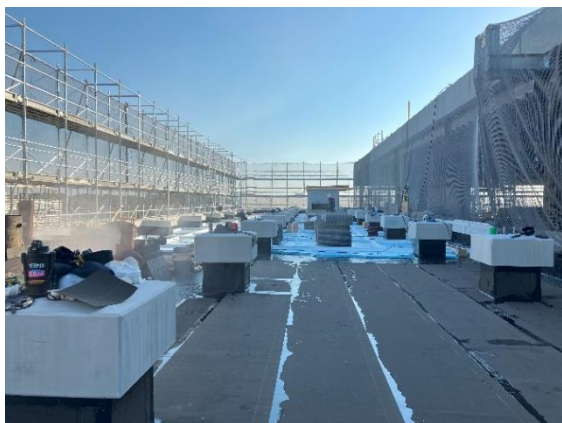
5階設備機器置場のアスファルト防水の状況です。(11/24)
