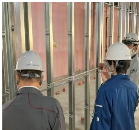
間仕切壁の軽量鉄骨下地の施工状況を確認しています。(11/24)
