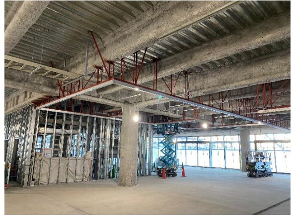
1階多目的スペースのスライディングウォールのレールが設置されています。(12/26)
