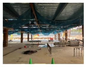
建方エリアの1階部分は不要資材がなく, 適切に管理されています。上階からの落下 物防止のための水平ネットも隙間なく設置 されていることを確認しました。(7/25)
