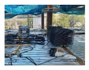
2階に搬入された鉄筋材料(重量物)は、 鉄骨梁に直接荷重がかかるように設置されていることを確認しました。 (7/25)
