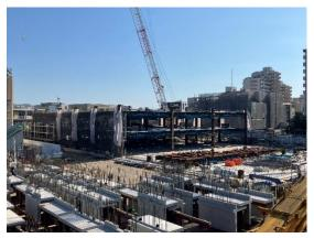
1節鉄骨建方が7/18より開始されました。 1節は約10mあり、3階の床を支える高さ まで組み上がります。地上鉄骨建方は順調 に進捗しています。(7/25)
