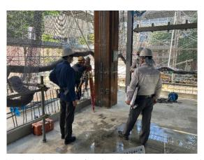
ボルト本締めおよび梁溶接完了部の鉄骨柱の建入精度を確認しました。写真は、施工された柱の倒れが管理許容差内であることを、1階部分で確認している様子です。 (7/25)
