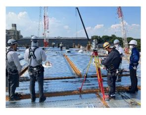
ボルト本締めおよび梁溶接完了部の鉄骨柱の建入精度を確認しました。写真は、施工された柱の倒れが管理許容差内であることを、3階部分で確認している様子です。(7/25)
