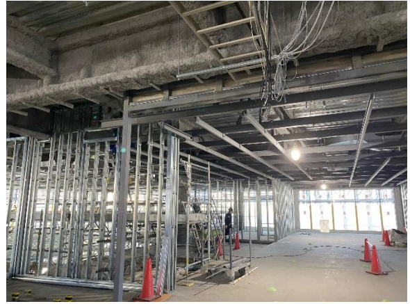
2階ロビー部分の天井下地が施工されています。 (1/25)
