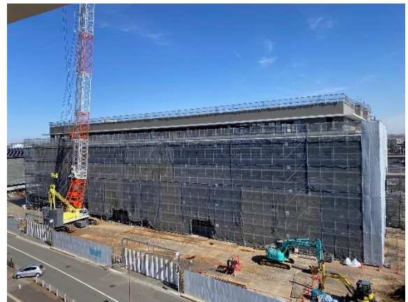
いずみプラザ屋上から現在の全景 (2/16)
