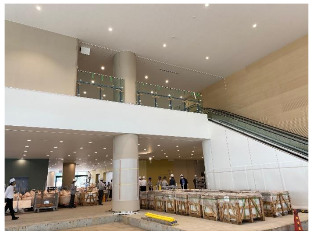
足場解体後のエントランスの状況。(6/11)
