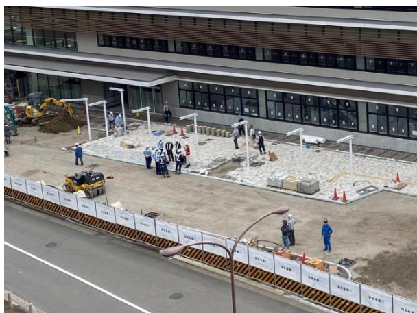
乗降スペースの屋根の鉄骨が設置されました。 (6/7)
