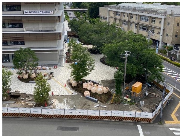
四小前交差点付近では、植栽工事や外構工事が 進んでいます。(6/7)
