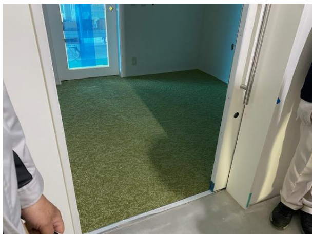
1階相談室の施工状況を確認しました。 (5/10)
