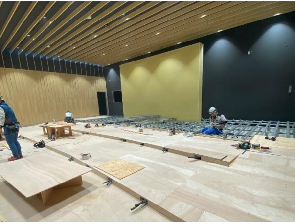
5階議場の段床工事を進めています。(6/11)
