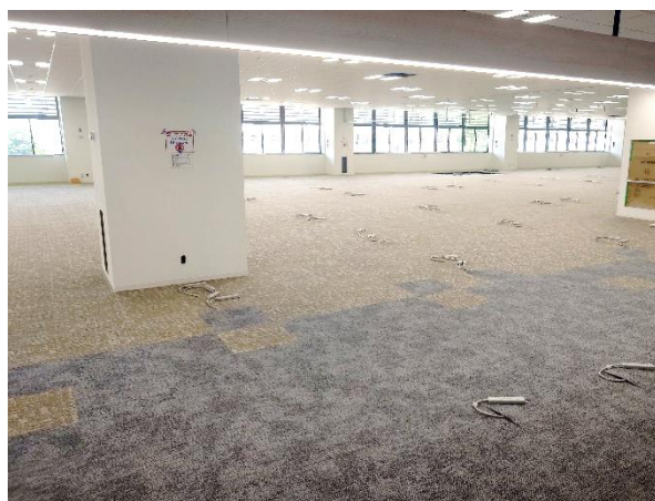
3階執務エリアのタイルカーペット (OAフロア)の施工状況。(6/11)
