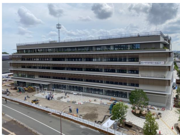
いずみプラザ屋上から現在の全景 (6/7) 外部足場は撤去されました。
