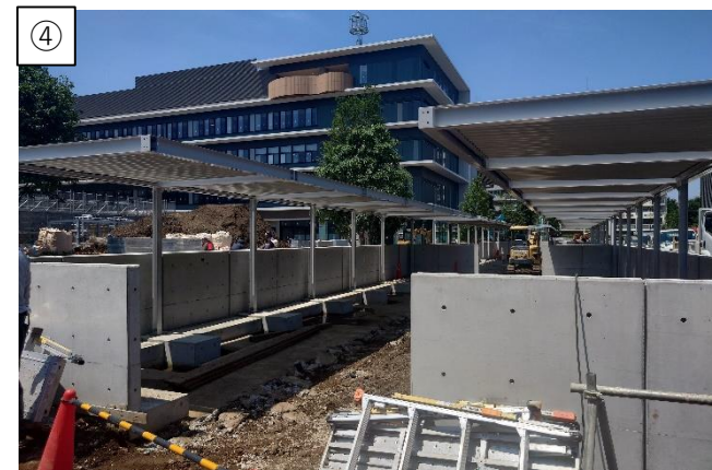
④ 多目的広場北側では、駐輪場及びバイク置場の工事が進んでいます。(7/5)
