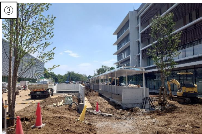
③ 庁舎北側では、駐輪場の工事が進んでいます。(7/4)
