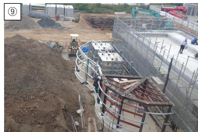
外構の喫煙所及び受水槽置場の工事が進んでいます。（7/9）
