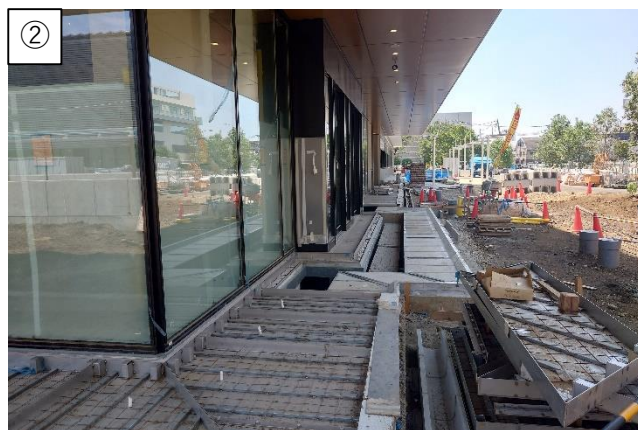
② メインエントランス付近では、免震EXP.Jカバーの工事が進んでいます。(7/4)
