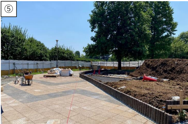
敷地東側では、武蔵国分寺公園内の接続通路の工事が進んでいます。（7/5）
