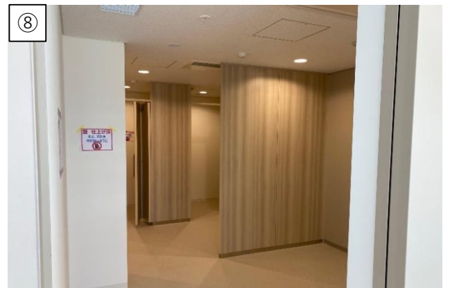
2階授乳室の施工状況です。（7/5）
