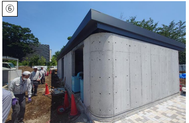
敷地の北東角付近では、土嚢置場・資材倉庫の工事が進んでいます。（7/5）
