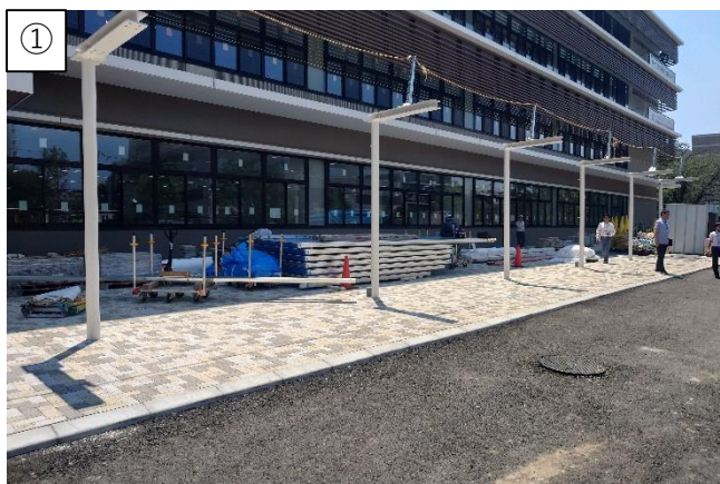
① 庁舎西側では、ぶんバス乗降スペースの工事が進んでいます。(7/4)
