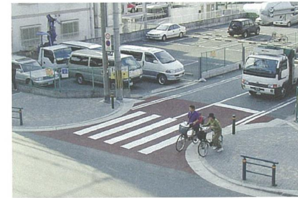
写真 2.2.2.25 交差点狭さく（大阪市東淀川区）
