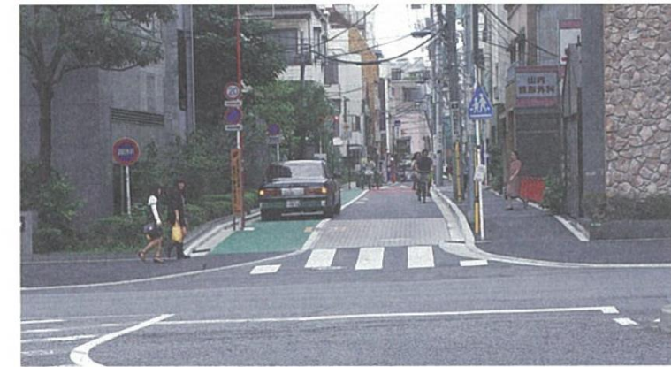
写真 2.2.1.17 路側帯に合わせて設置した歩道すみ切り部 (東京都文京区白山)
