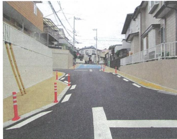
写真 2.2.2.32 クランク型シケイン (綾瀬市寺尾釜田地区)
