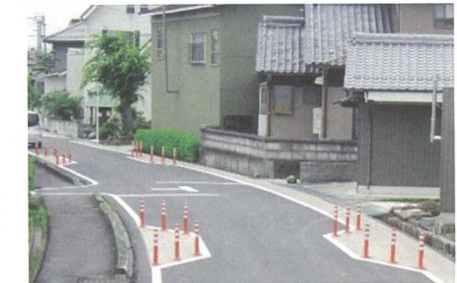
写真 2.2.2.28 狭さくの連続設置（愛知県稲沢市）
