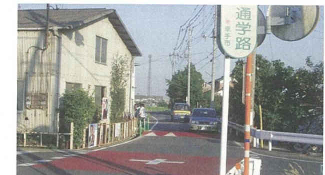
写真 2.2.2.10 交差点入口ハンプ （埼玉県幸手市）
