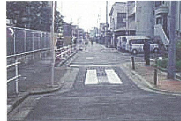
写真 2.2.2.23 歩道張り出しによる狭さく（名古屋市西区）
