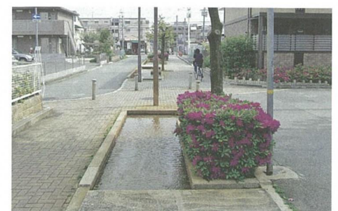
写真 2.2.2.38 遮断された南北道路の歩道整備 (兵庫県尼崎市塚口地区)
