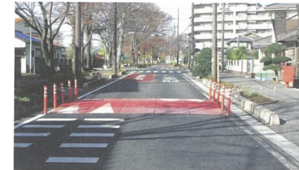
写真 2.2.2.9 交差点入口ハンプ （埼玉県鶴ヶ島市）
