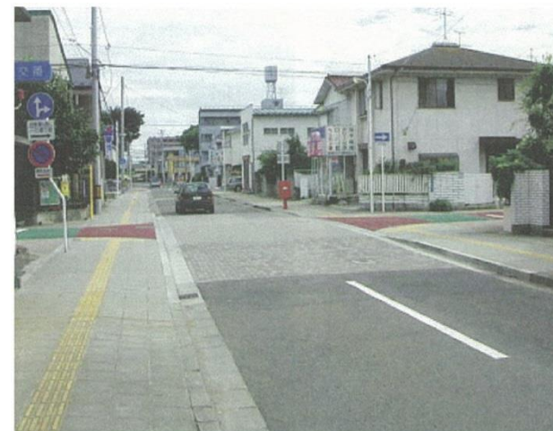
写真 2.2.2.16 交差点全面ハンプ（仙台市若林区）
