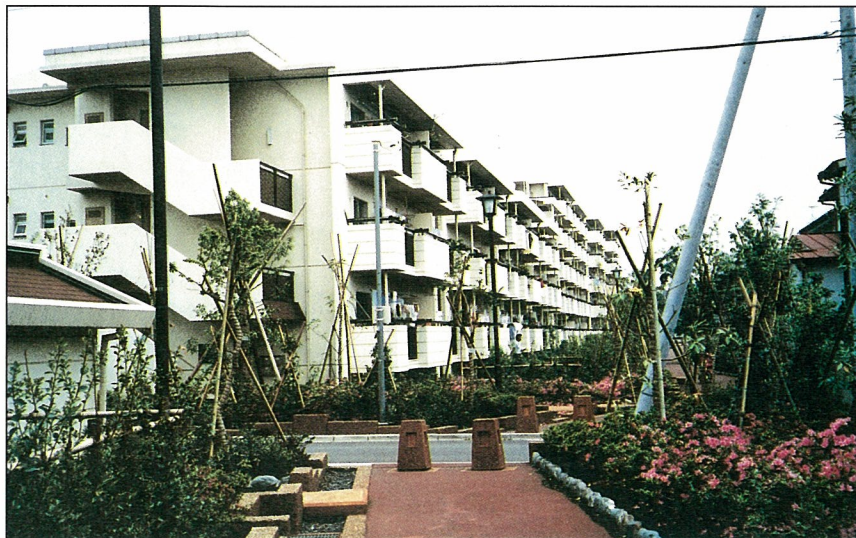
都営住宅(中層棟)▼
