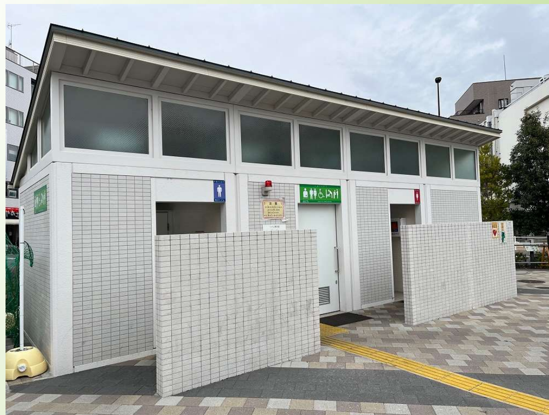
事例：国分寺駅北口駅前広場公衆トイレ
