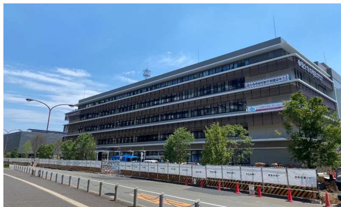
令和7年から供用開始する新庁舎
