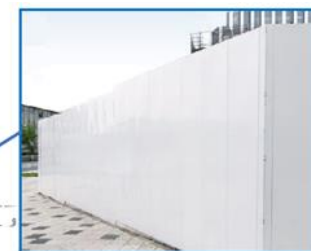
フラット 仮囲いH3.0m
