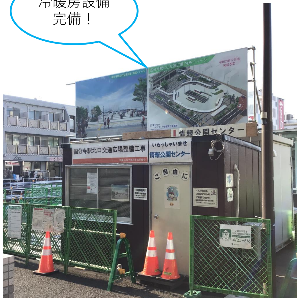
設置イメージ写真 (国分寺駅北口駅前再開発時)
