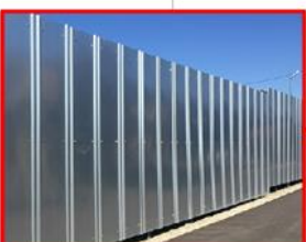
成形鋼板仮囲いH3.0m
