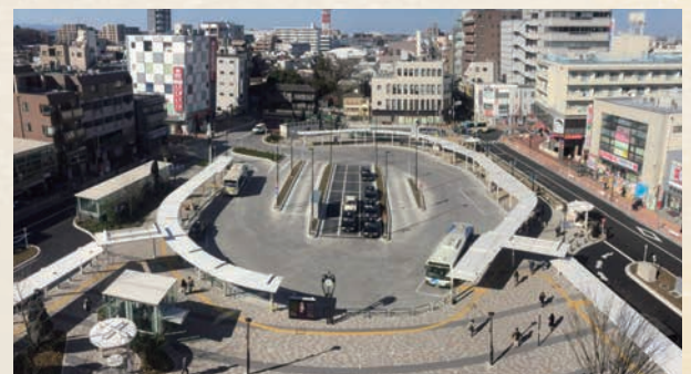
再開発後の国分寺駅北口広場
