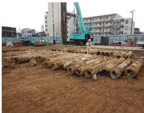
杭 撤去完了 令和8年2月24日
