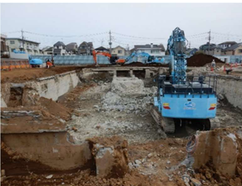
地下躯体 解体状況 令和8年3月13日
