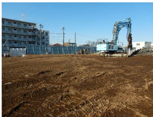
基礎 解体完了 令和8年1月30日
