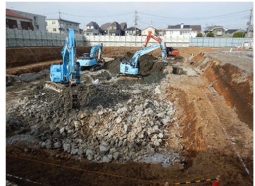
地下躯体 解体状況 令和8年4月17日
