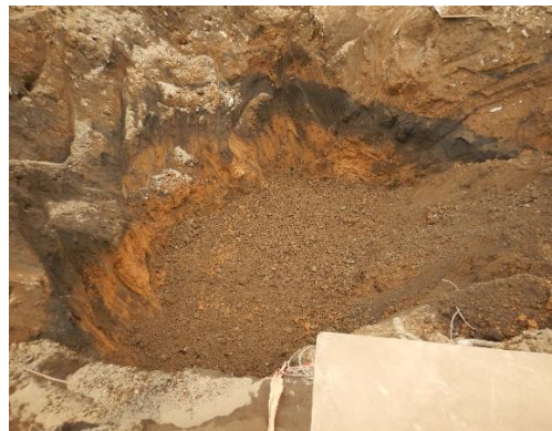
防火水槽解体完了 令和8年6月24日
