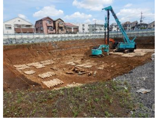
杭抜き施工状況 令和8年6月19日
