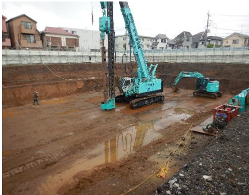
杭抜機組立状況 令和8年6月8日
