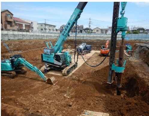
杭抜き施工状況 令和8年6月16日
