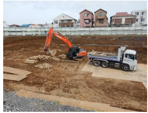
引き抜き杭搬出 令和8年6月24日
