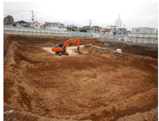
杭抜き工事完了 令和8年6月24日
