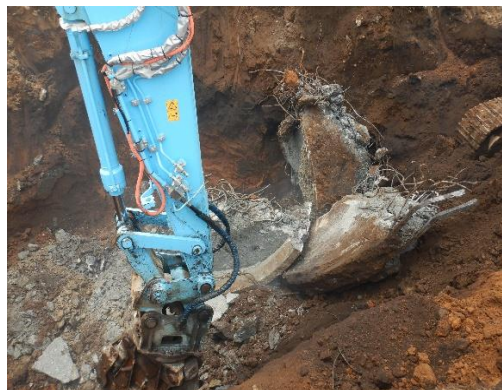
防火水槽解体状況 令和8年6月24日
