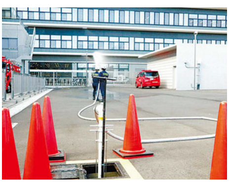
スタンドパイプを使った初期消火
