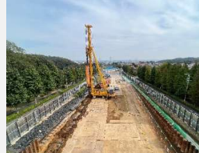
ICT建機による地盤改良工
